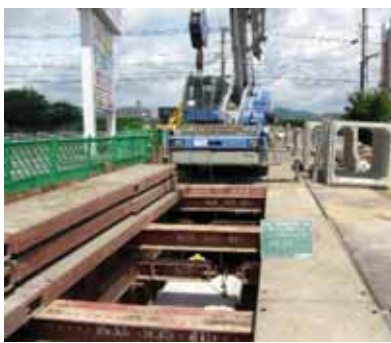
▲大原地区排水路工事
